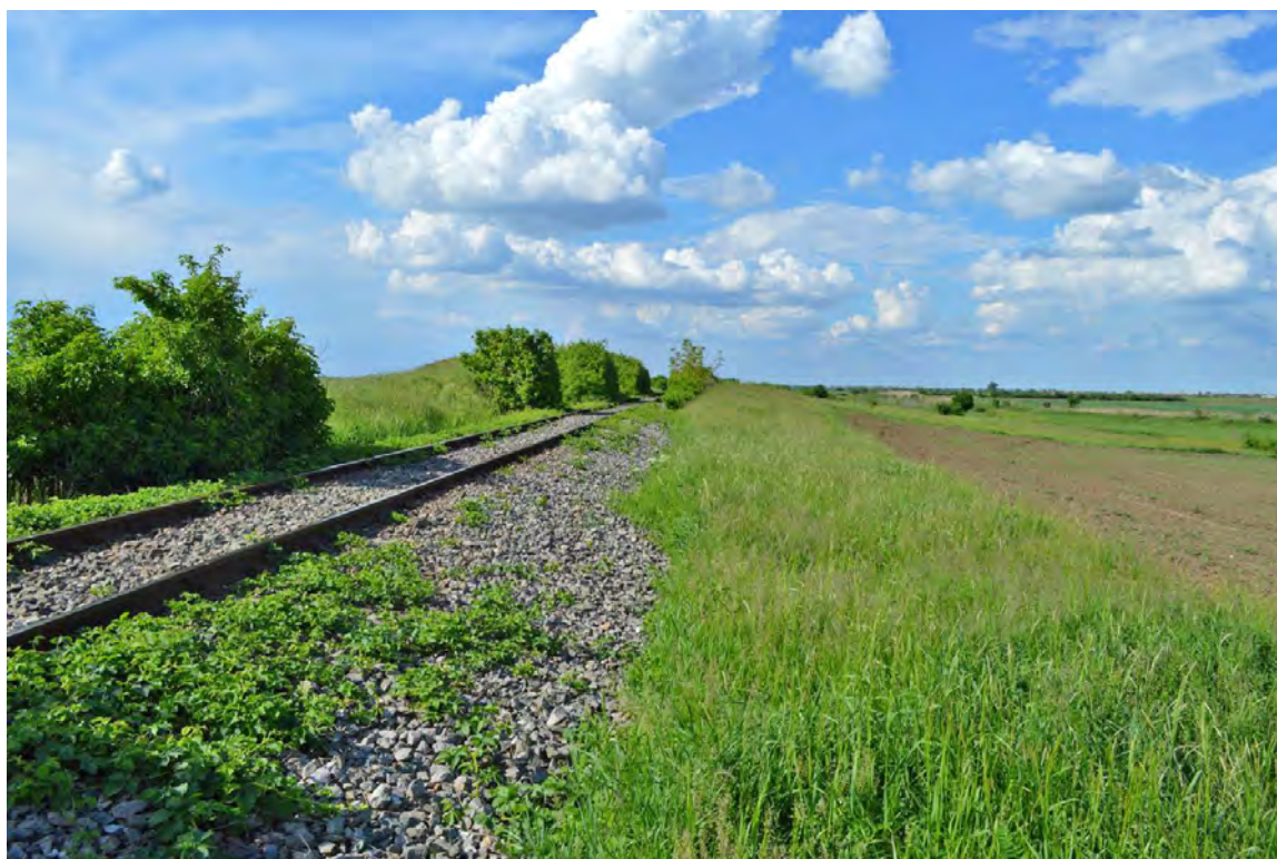
Vedere dinspre S, 15.05.2021
